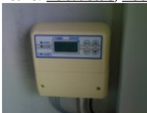
Solaris juhtautomaatika - termoandurid, Päikeseküttekomplekt Mega + pumba juhtimine, kaitsefunktsioonid üks lisapaneel
